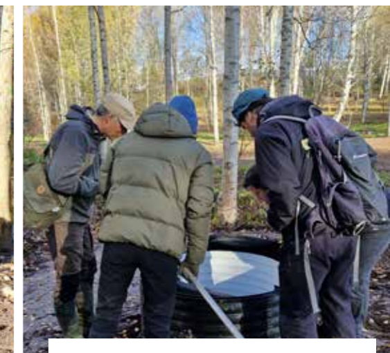
Utloppet där vattennivån regleras med en "munk".
